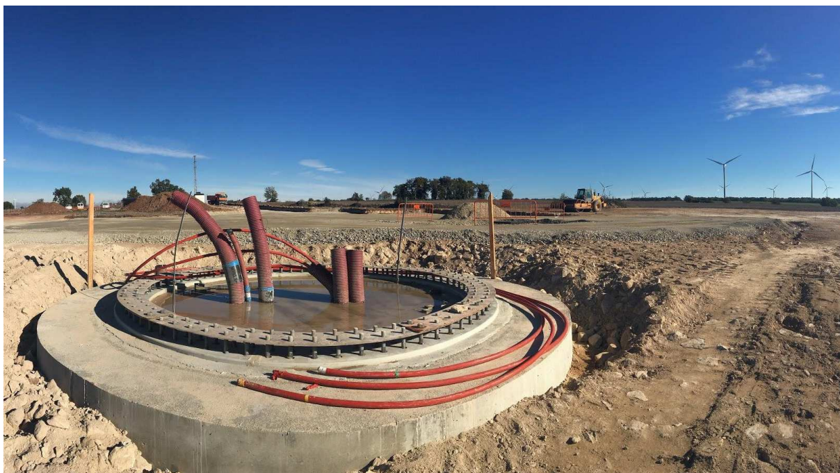
El fonament preparat per l'arribada del molí
