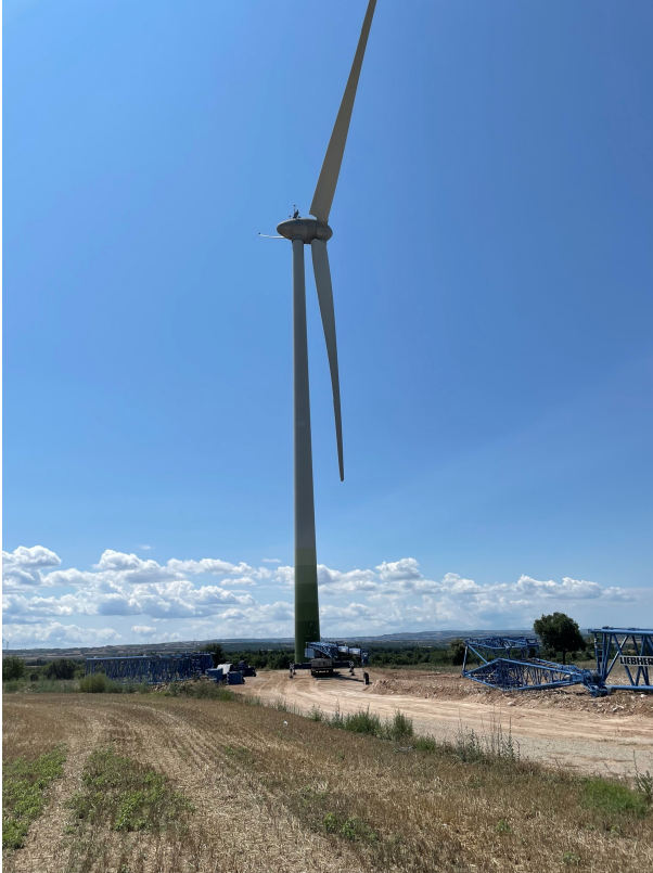
Adequació dels accessos
