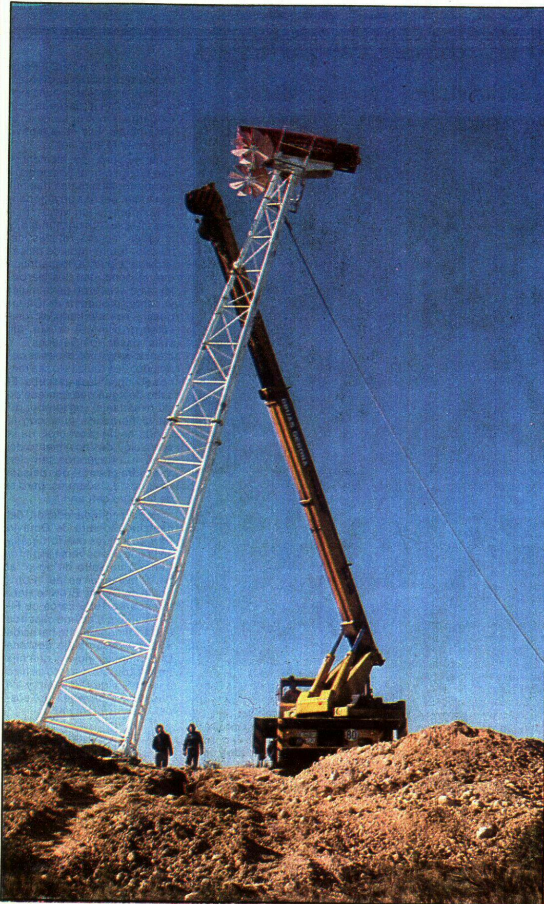
Erección del aerogenerador sin palas
